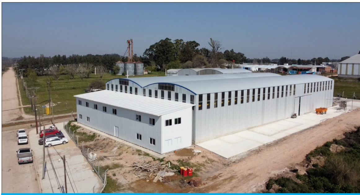
# Las nuevas instalaciones de Metalúrgica Cabrera en el Parque Industrial.
